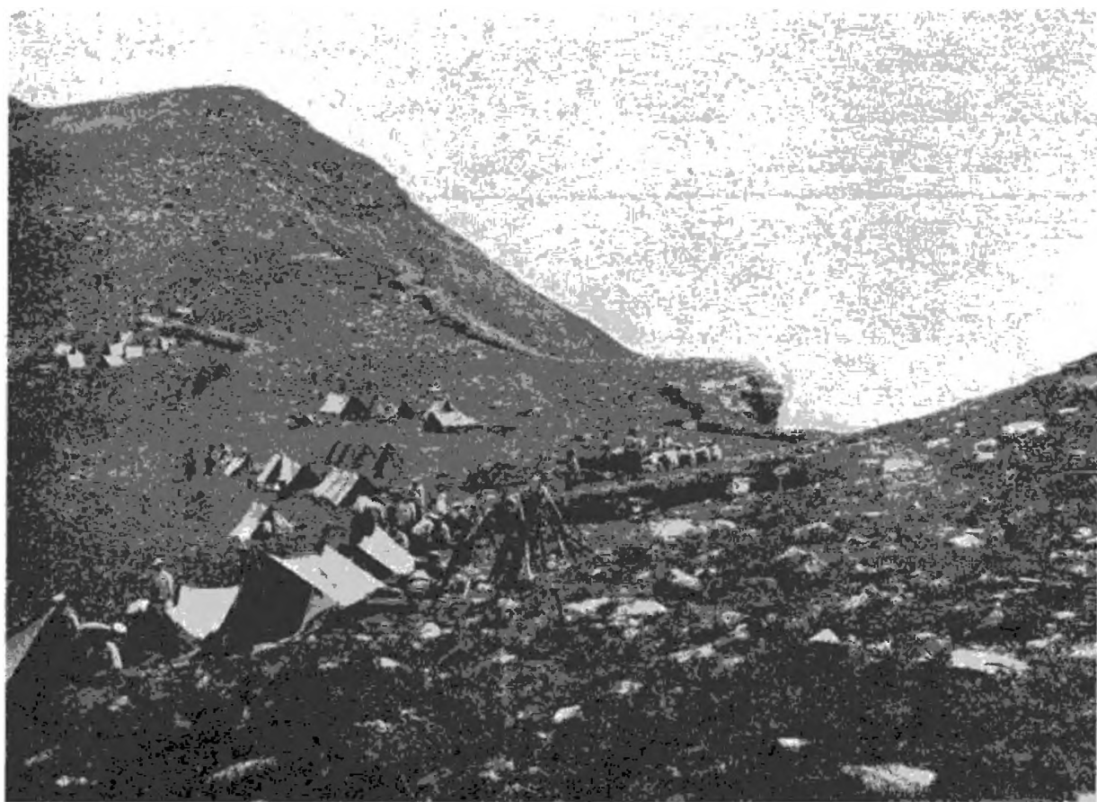
Работы по укрѣпленію центра „Позиціи на перевалахъ“. Позиція 5-й роты 14-го полка.
