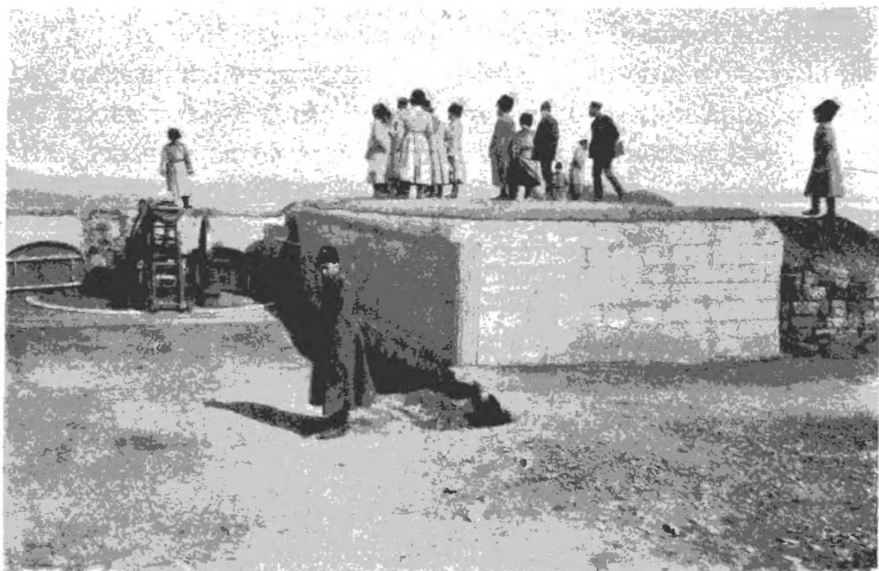
Батарея лит. А
