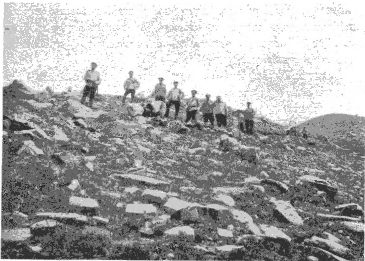
Работы по укрѣпленію центра „Позиціи на перевалахъ“.
