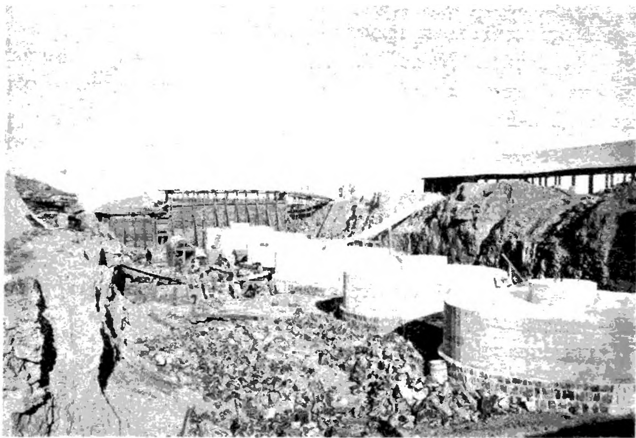
Устройство основаній для установки орудій на береговой батарее.
